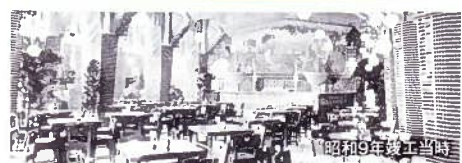
昭和9年竣工当時
